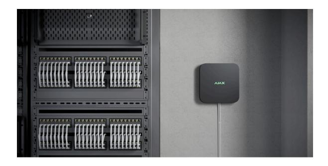
É aconselhável escolher um local de instalação onde o NVR esteja escondido de olhares indiscretos, por exemplo, na despensa. Isso ajudará a reduzir a probabilidade de sabotagem. Note que o aparelho se destina apenas a instalação no interior.
