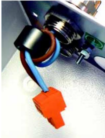
Figura 8: Enrolar cabos de ligação de relé em redor de uma ferrite de supressão
