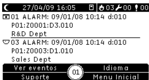
Figura 3: Indicação de alarme de incêndio no ecrã LCD do painel de controlo
